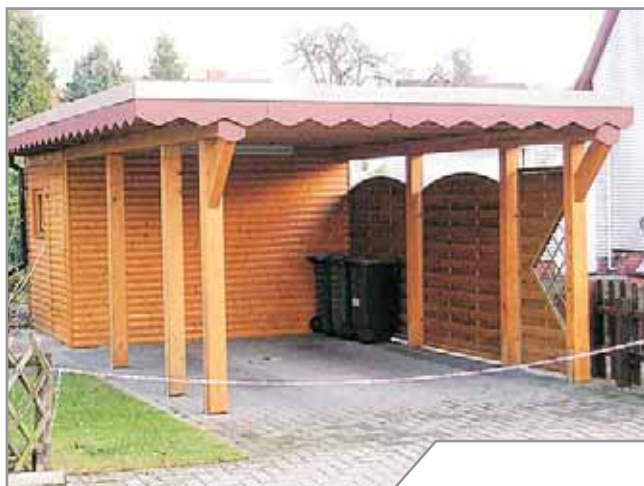
Errichtung eines Carports nach Ausführungsplänen der JGI in Celle
