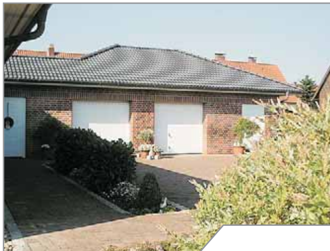
Doppelgarage mit Abstellraum, zugehörig zum Einfamilienwohn- haus in Müden/Örtze
